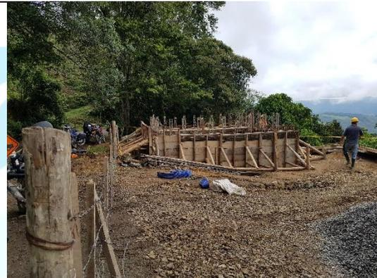
Foto Construcción Tanque de Almacenamiento Acueducto Interveredal Argelia
